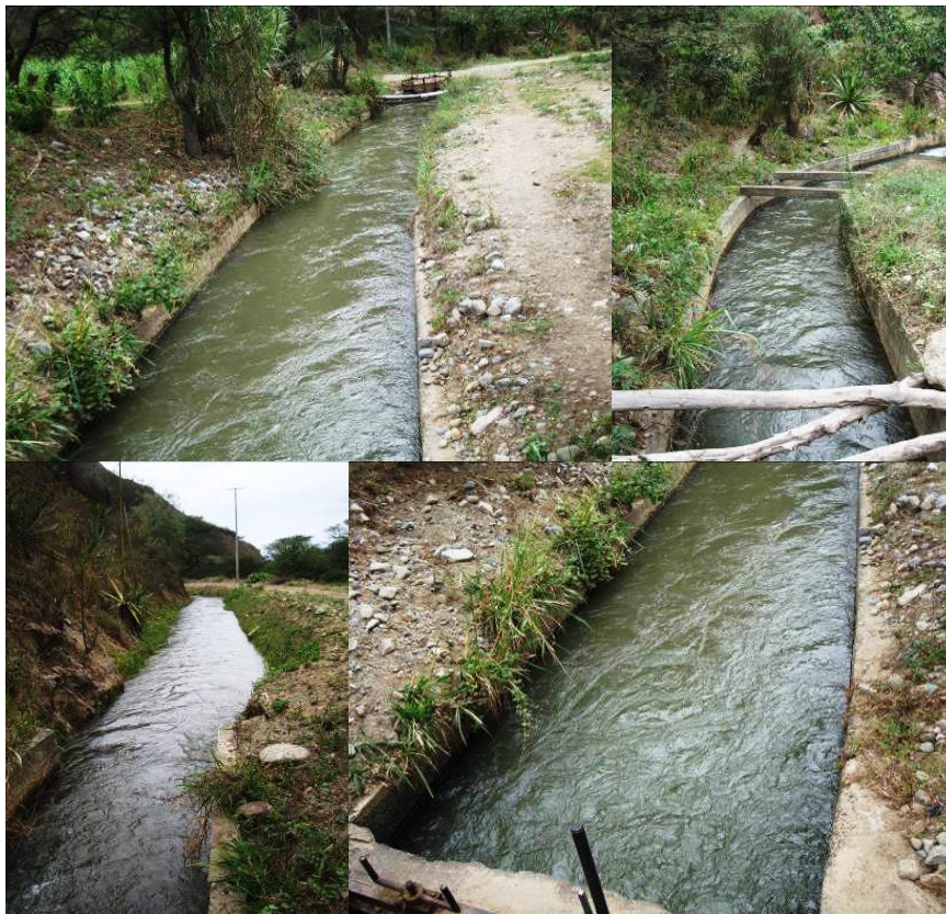
Captaciones de agua en el río Guayabal
