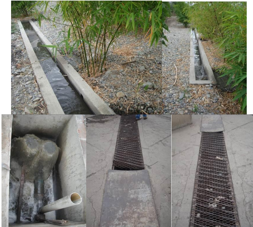
Vista parcial de canales de drenaje
