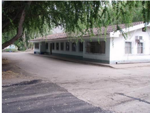
Instalaciones de la oficina de campo
